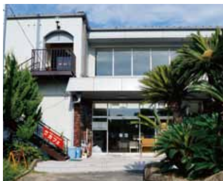
センター左側の階段を2階に上がってください
